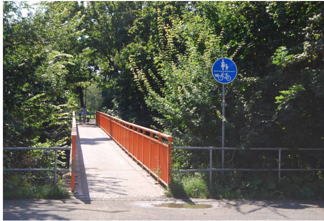
Fußgängerbrücke am Nettelbeckufer (Geraquerung, Anbindung Nordpark)
