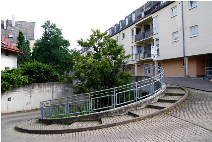
Tiefgarage Gisperslebener Straße (Einfahrt)
