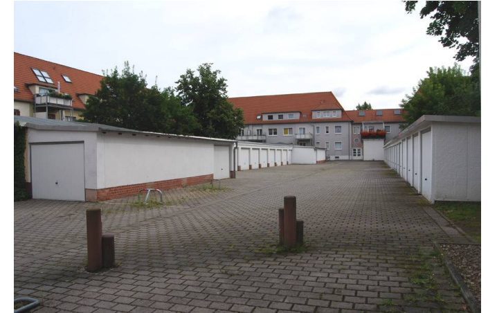
Garagenkomplex Rehleite (Innenhof)
