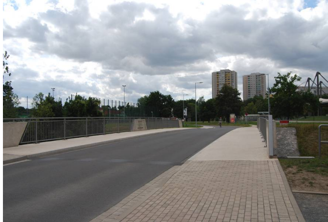
Brücke an der Radrennbahn - Geraquerung (Andreasvorstadt, Stadtteil Berliner Platz)
