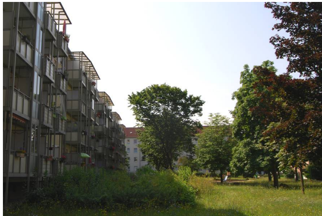
Grünanlage Hasenwende/ Fuchsgrund
