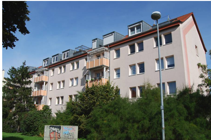
Wohnblock Gisperslebener Straße
