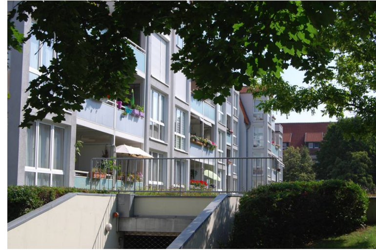
neuer Wohnblock (Blick von Hasenwende)
