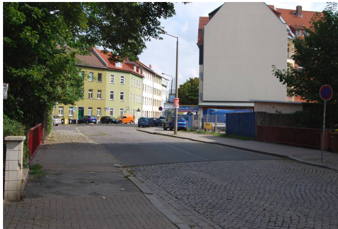
Brücke Papiermühlenweg (Querung der Schmalen Gera)
