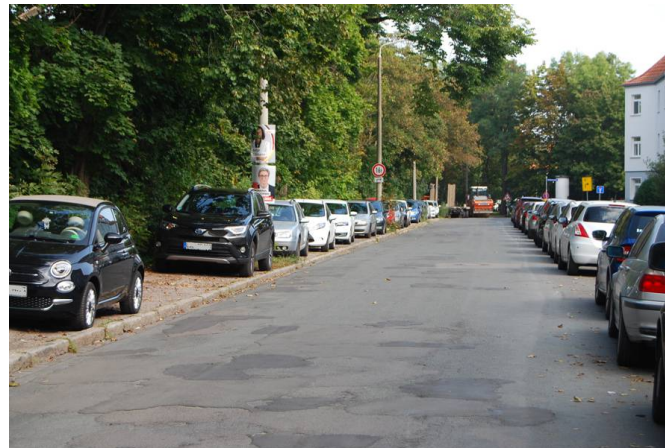
Nettelbeckufer (Durchgangsstraße, Nord-Süd-Verbindung an westlicher Gebietsgrenze)
