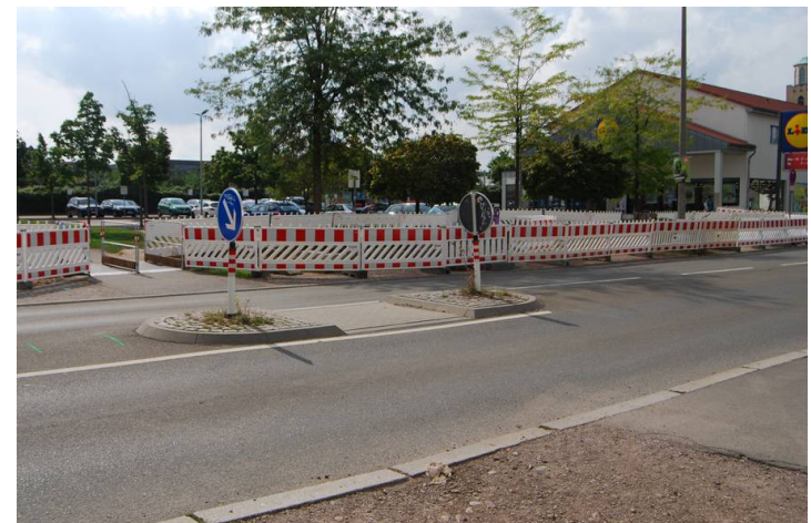
Fußgängerinsel in der Eislebener Straße (Querung zu Lidl und zum Stadtteilpark Johannesfeld)
