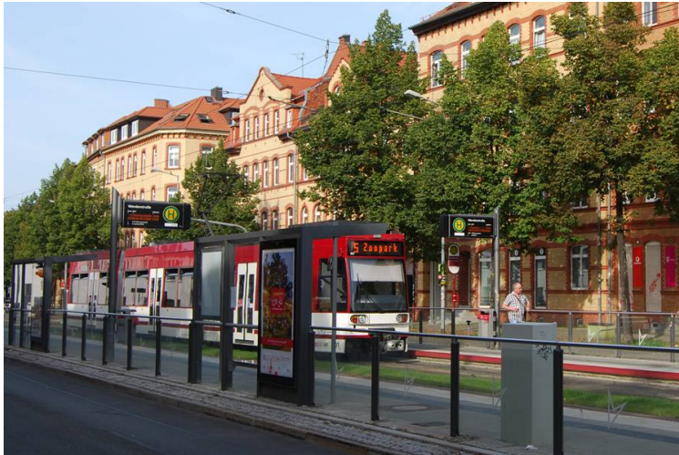
Stadtbahnhaltestelle Wendestraße (Rtg. Roter Berg, Rieth/ Europaplatz und Altstadt)
