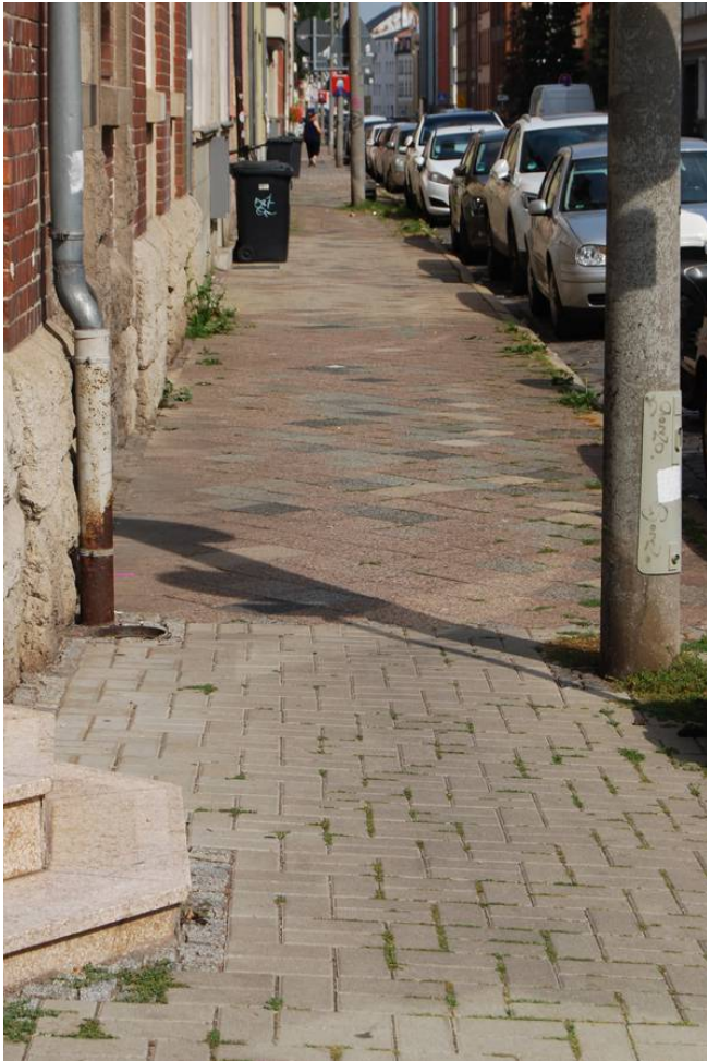
Gehweg Hans Sailer Straße
