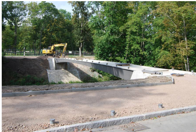
Fußgängerbrücke in Höhe Lessingschule, in Bau (Anbindung Lutherschule und Nordpark)
