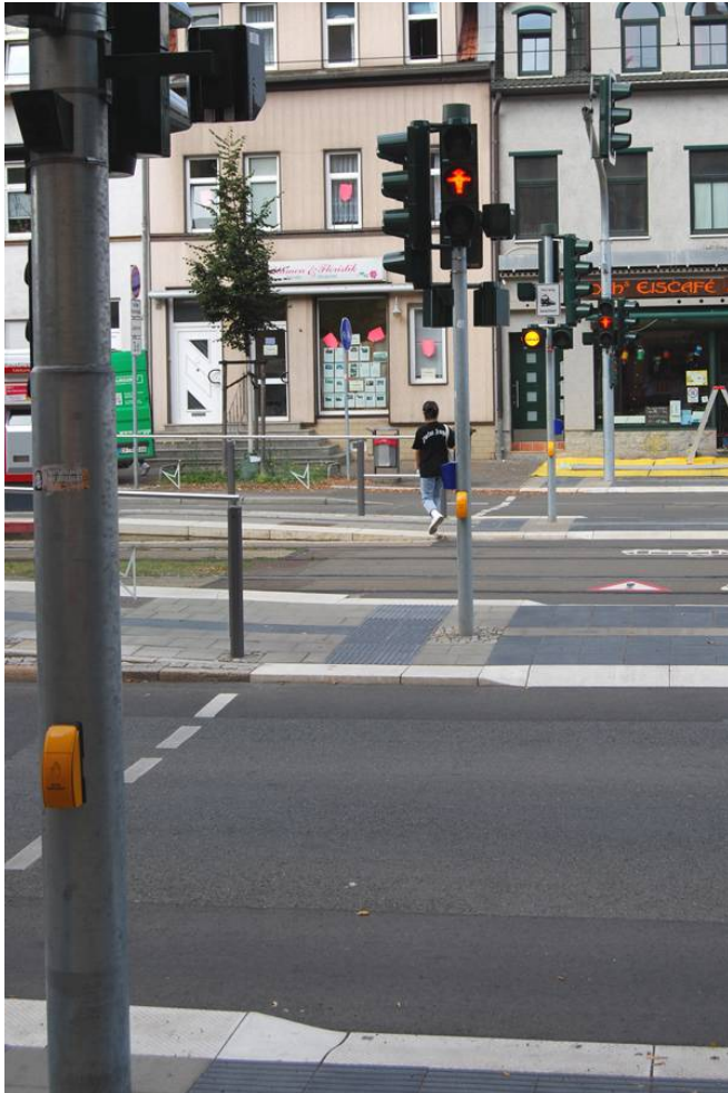
Ampelanlage Magdeburger Allee, Höhe Wendenstraße (barrierefreier Überweg mit Zugang zur Stadtbahn- haltestelle)
