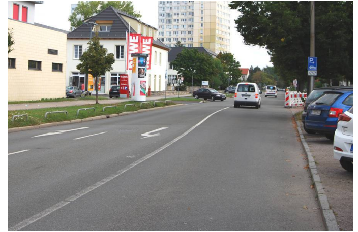
Eislebener Straße (Durchgangsstraße, West-Ost-Durchquerung)
