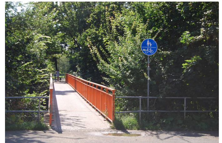
Fußgängerbrücke in Höhe Kolpingstraße (Anbindung Nordpark)
