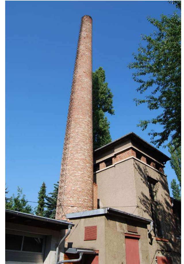
altes Heizwerk (Papiermühlenweg)
