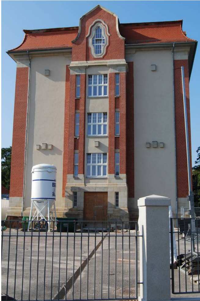
Gemeinschaftsschule, Karlsstraße (ehemalige Lutherschule)
