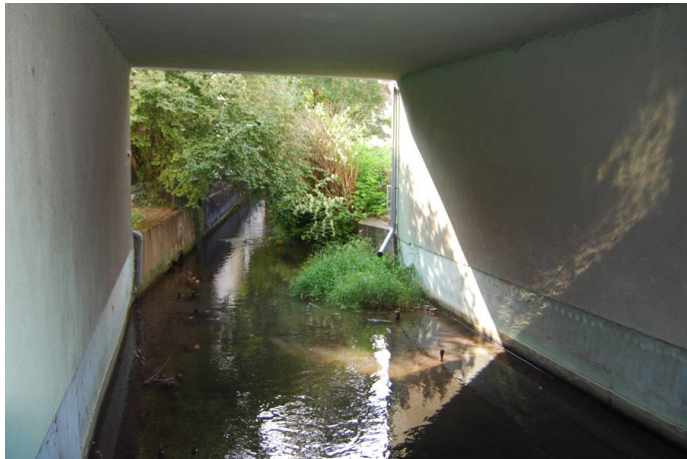
Haustunnelung in der Spittelgartenstraße (Richtung Papiermühlenweg)
