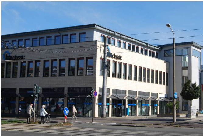
Bürohaus, Ecke Magdeburger Allee/ Eislebener Straße
