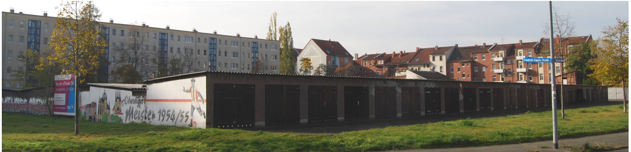
Garagenkomplex, Ecke Salzstraße/ Fr.-Engels-Straße)
