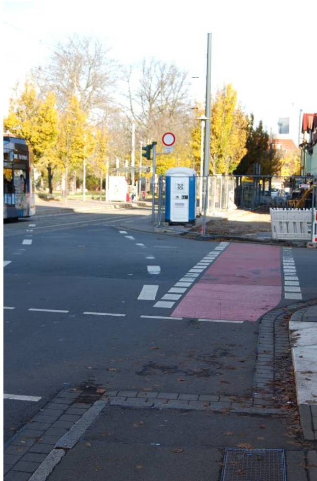
Radwegquerung Stollbergstraße (2010) (in Richtung Salinenstraße)
