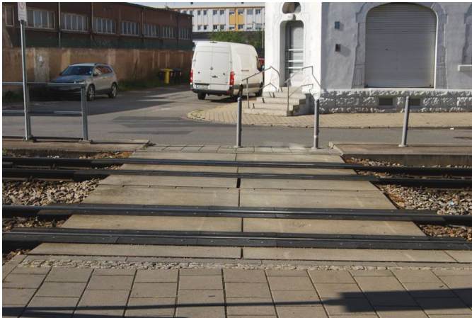
Querung Magdeburger Allee, Höhe Teichstraße (nicht barrierefrei, keine Ampelanlage)
