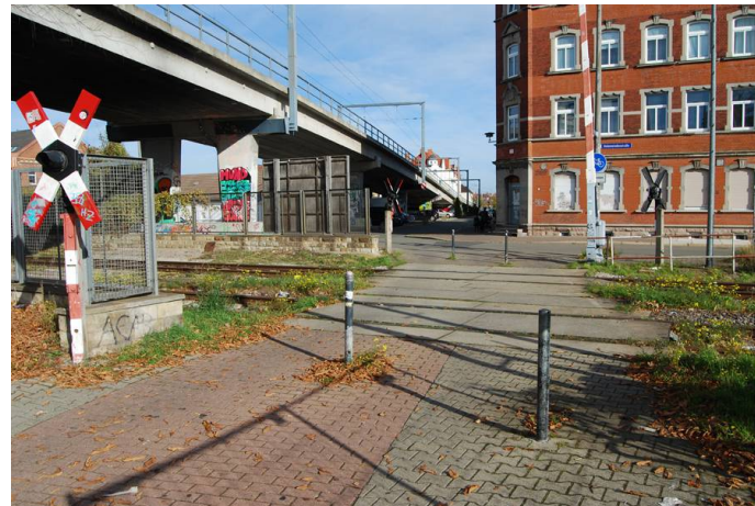
Magdeburger Allee (Rtg. Grubenstraße) (beschränkter Bahnübergang, nicht barrierefrei)
