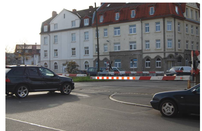
Salinenstraße (beschränkter Bahnübergang)
