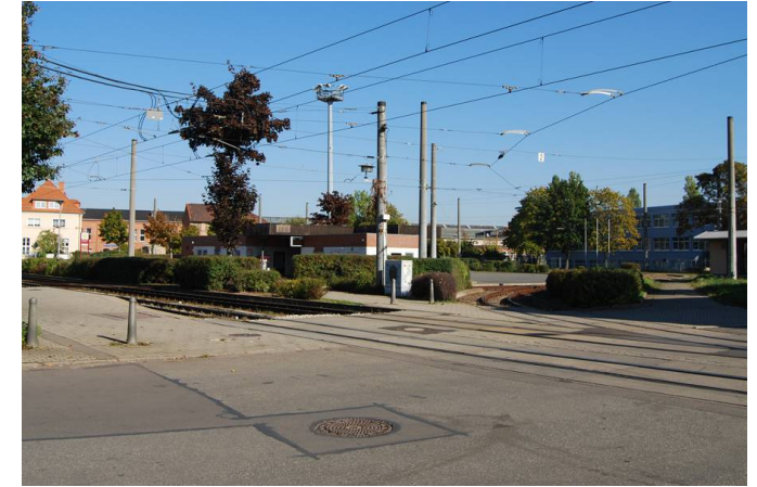
Querung Magdeburger Allee, Höhe Busbahnhof (nicht barrierefrei, keine Ampelanlage)
