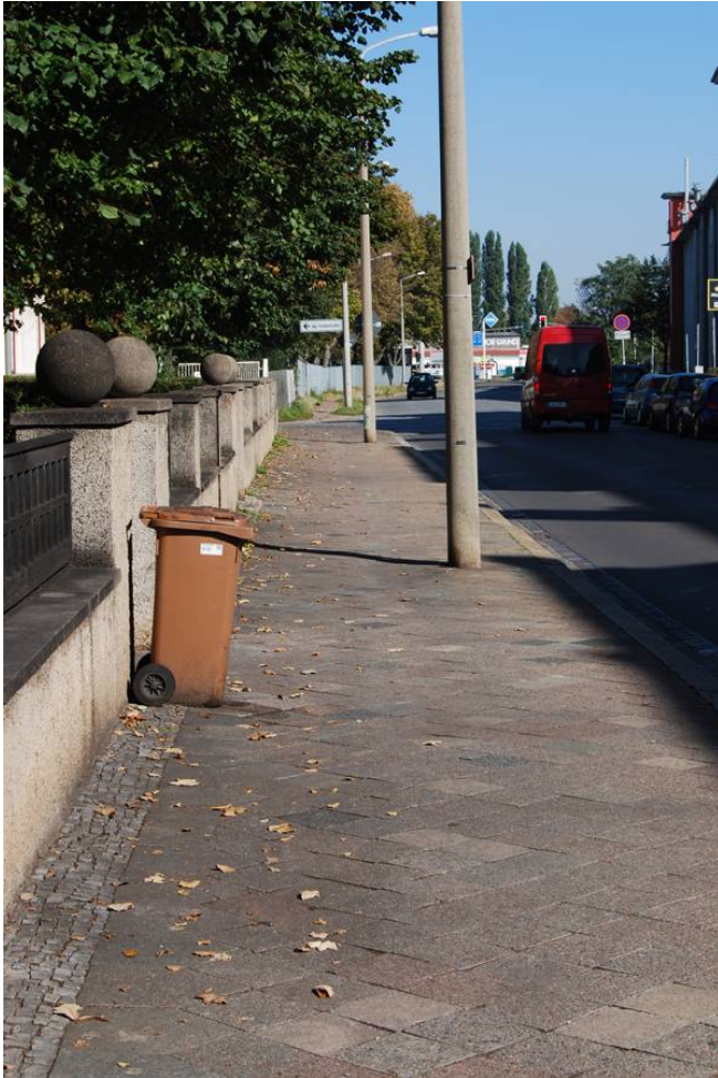
Gehweg Salinenstraße (linke Straßenseite)
