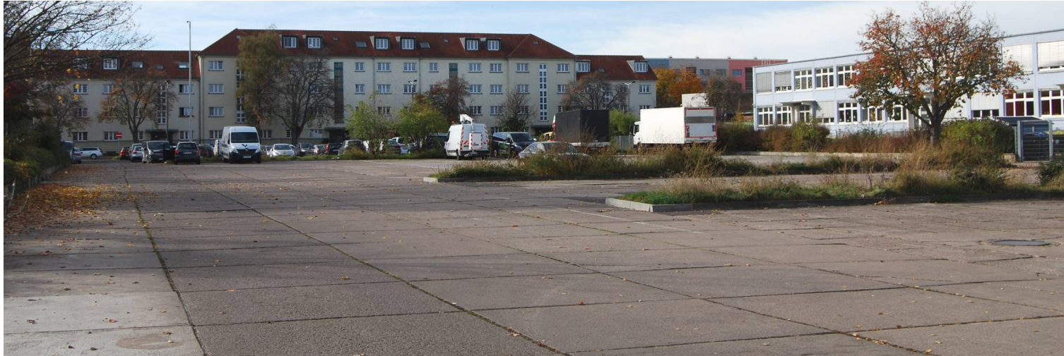
Blick von Einfahrt Hugo-John-Straße (sanierungsbedürftig)
