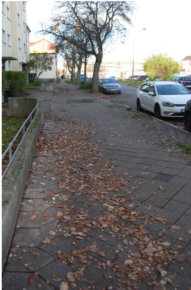
Gehweg Grubenstraße (Teilstrecke bis zur Magdeburger Allee)
