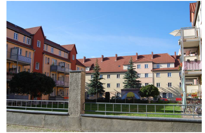
Wohnblocks mit Grünanlage im Innenhof (Blick von Neuendorfstraße zur Barkhausenstraße)
