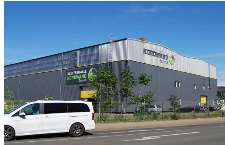
Kletterhalle "Nordwand", Mittelhäuser Straße (2019)
