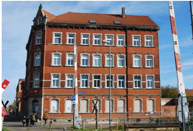
Ecke Magdeburger Allee/ Hohenwindenstraße (Sanierung 2021)
