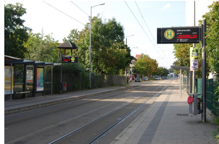
Stadtbahn, Haltestelle Salinenstraße, Gleis 1
