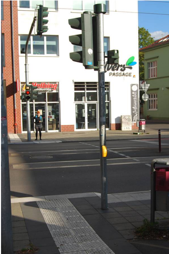
Ampelanlage Magdeburger Allee in Höhe Filßstraße (barrierefreier Überweg)
