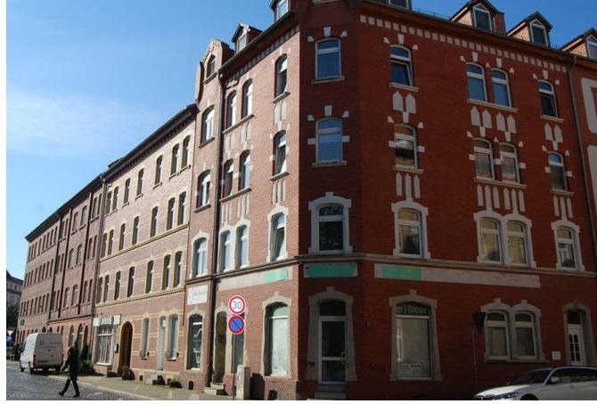
Ecke Ilversgehofener Platz/ Braunstraße
