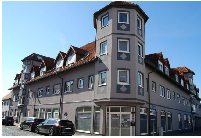
Mehrfamilienwohnhaus mit Gewerbe im Erdgeschoss, Ecke Hans-Sailer-Straße/ Bogenstraße
