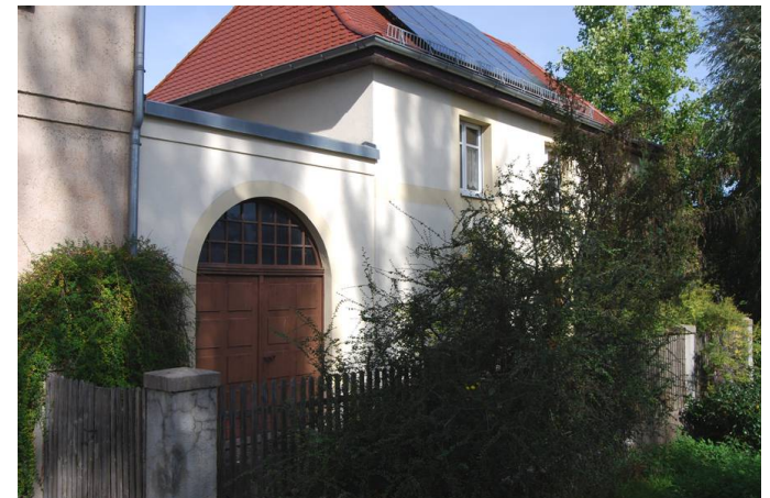
Gehöft mit Hofeinfahrt, Tiergartenstraße
