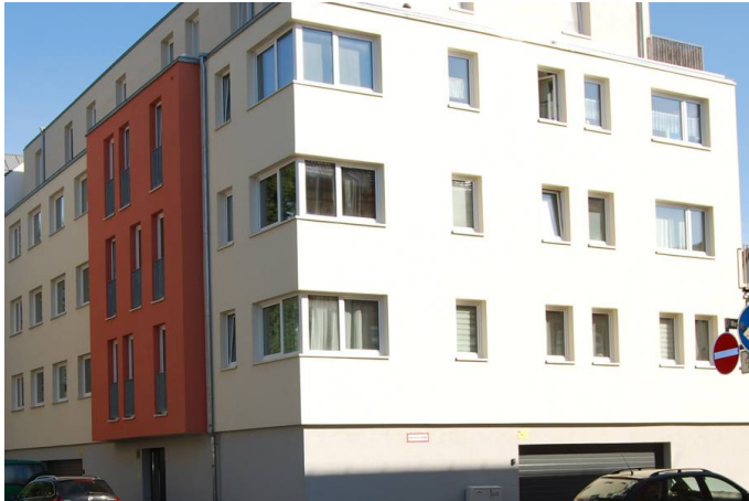
Mehrfamilienwohnhaus, Hans-Sailer-Str./ Wendenstr.
