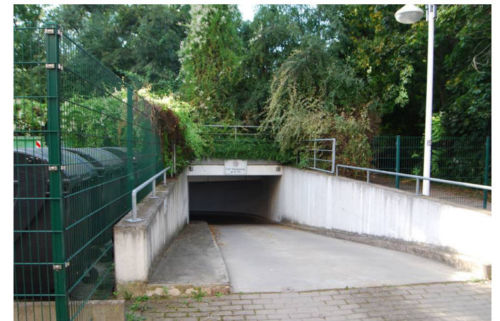
Tiefgarageneinfahrt mit nebenan angeordneten Müllcontainerstellplatz
