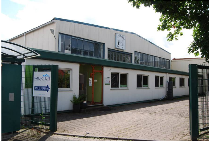
Condomi, Tiergartenstraße/ Wermutmühlenweg
