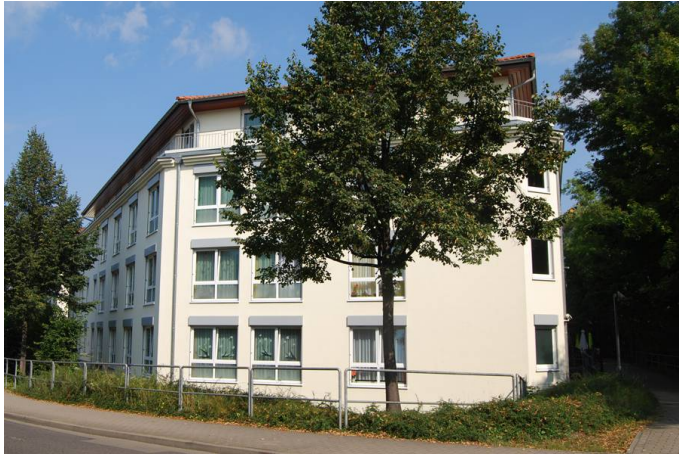
Wohnhaus zwischen Wermutmühlenweg und Fußweg an der Schmalen Gera
