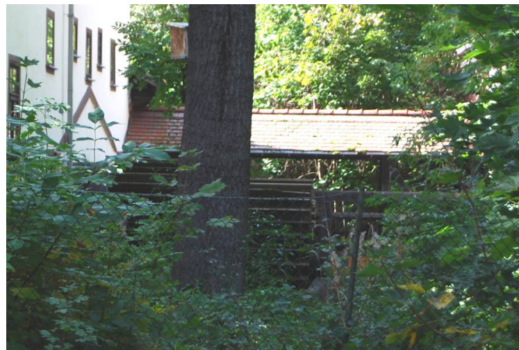
Mühlengang mit drei Wasserrädern
